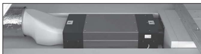
Montaje en en falso techo.
