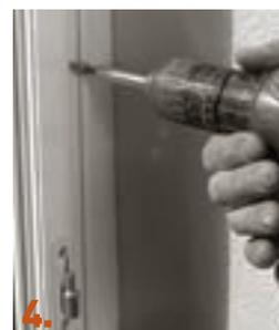
4. Colocación del marco nuevo mediante reguladores o atornillados y realización de un cordón continuo de estanqueidad.
