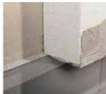
Remate de zócalo con perfiles de esquina con malla
