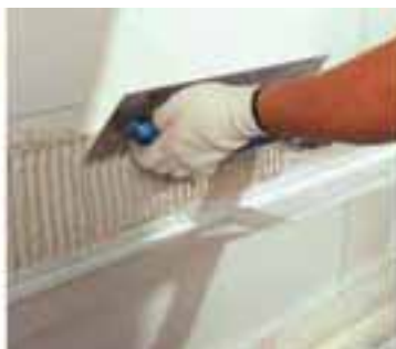
Remate de zócalo con perfiles de esquina con malla
