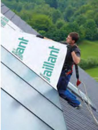
La configuración de la estructura ha sido diseñada para que el montaje se realice mediante el sistema "plug and play" y así minimizar tanto el tiempo de montaje como el nº de piezas a montar. Los soportes incluyen los accesorios de montaje y kits básicos y de ampliación de conexiones hidráulicas.
