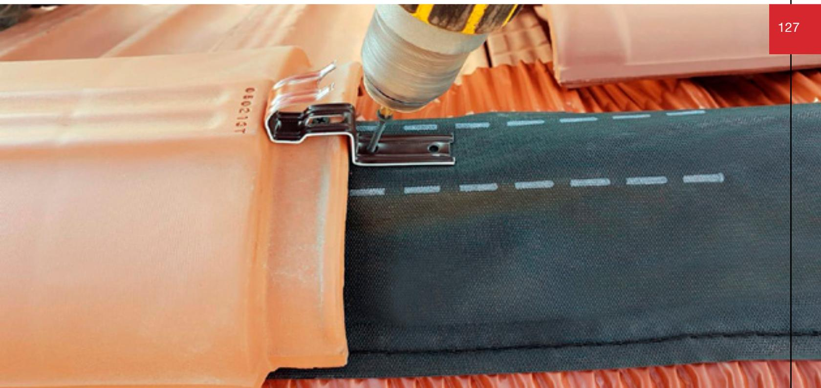
Para resolver adecuadamente encuentros con paramentos y chimeneas se utilizarán las bandas impermeabilizantes Multiusos. Una vez adheridas al paramento limpio y seco, se deberán rematar superiormente con el Perfil Lagrimero, sellando la línea superior con un cordón continuo de masilla.
