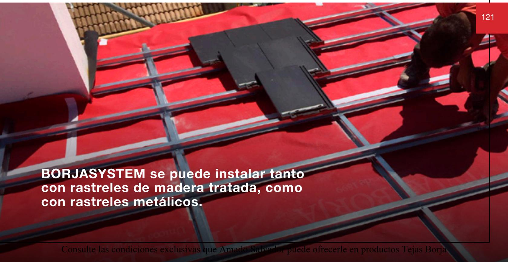
**BORJASYSTEM se puede instalar tanto con rastreles de madera tratada, como con rastreles metálicos.**
