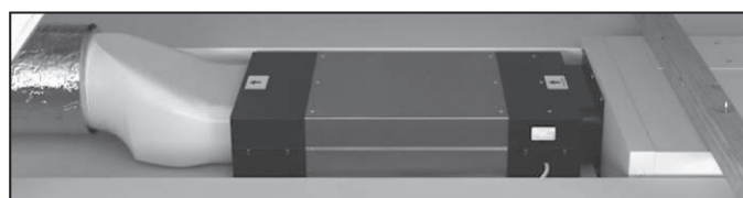
Montaje en falso techo.
